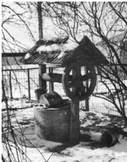
Spie. Studnia z kołowrotem w ogrodzie przy budynku „starej” szkoły podstawowej
