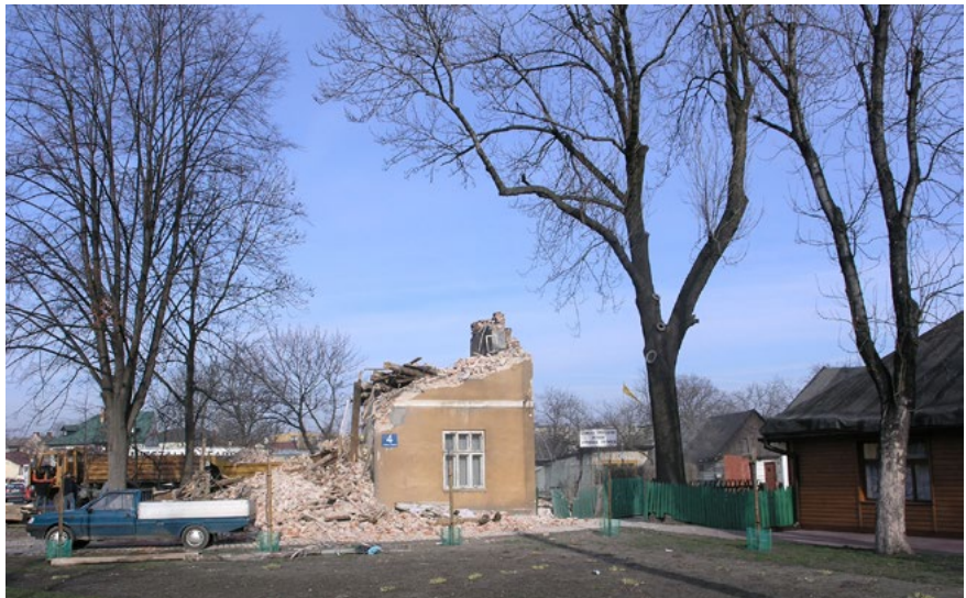
Rozbiórka starej żydowskiej kamieniczki przy ul. Nowy Rynek 5. Luty 2007 r., fot. W. Gąsiewski
