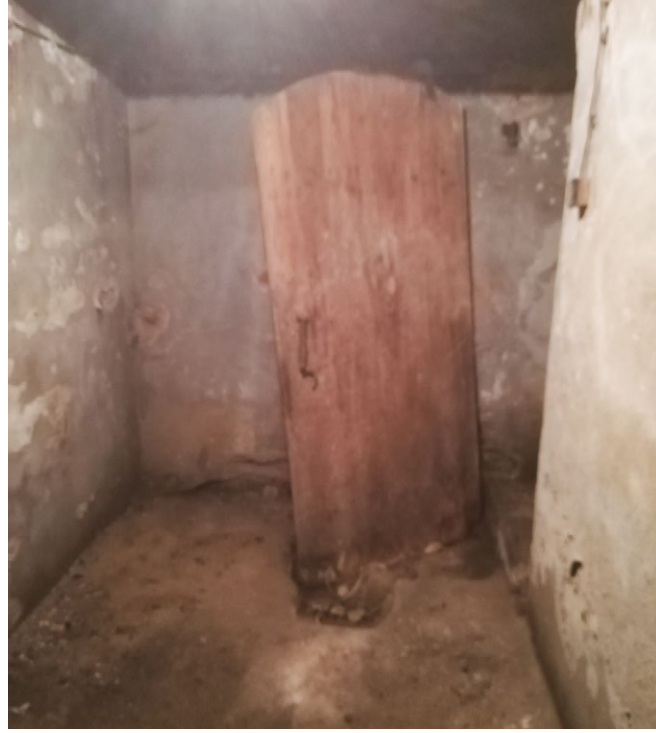
Piwnice. Fot. A. Krempa 2020 r.
