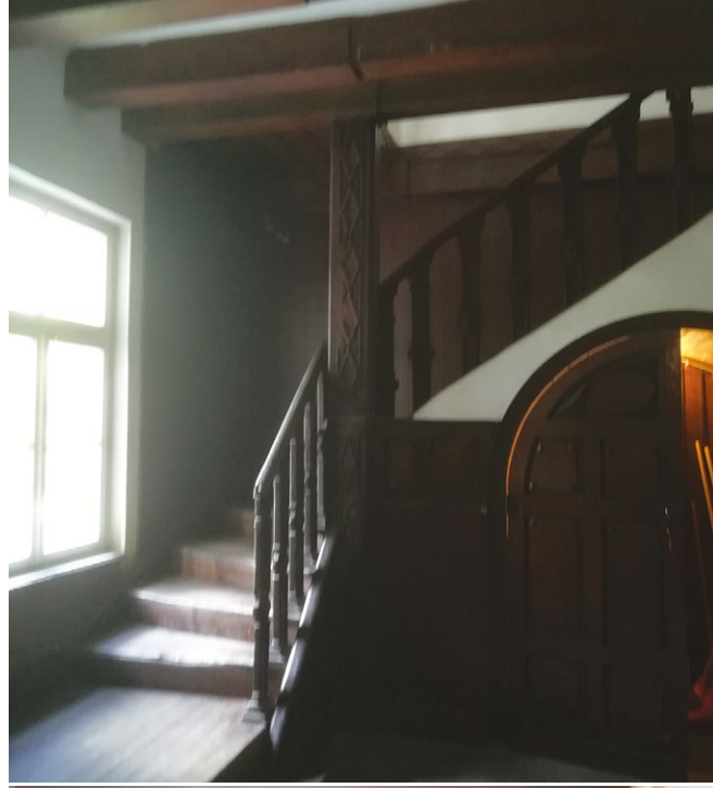
Klatka schodowa prowadząca na poddasze. Fot. A. Krempa.
