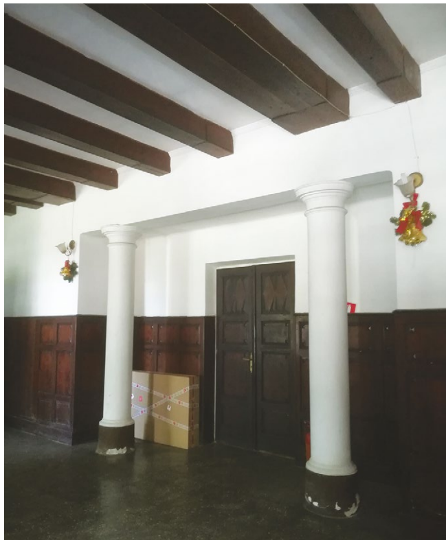
Ogólny widok holu z widocznymi drzwiami do salonu. Fot. A. Krempa 2020 r.
