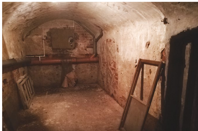
Piwnice. Fot. A. Krempa 2020 r.
