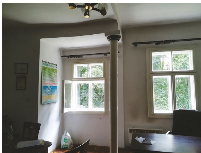
Jeden z pokoi mansardowych od strony wschodniej z wnękami wspartymi na drewnianych słupach. Fot. A. Krempa 2020 r.
