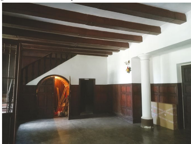
Centralne miejsce dworu - hol. Fot. A. Krempa 2020 r.
