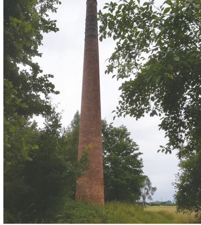
Zachowany komin gorzelni we Frankówce. Fot. A. Krempa.
