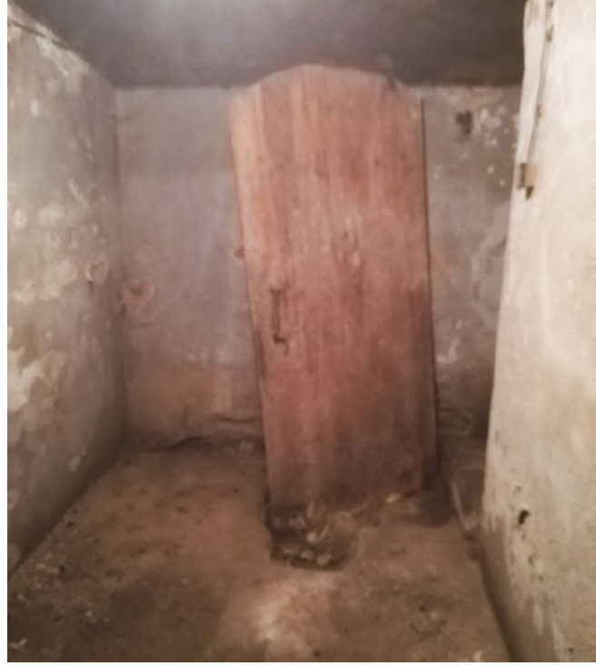
Piwnice. Fot. A. Krempa 2020 r.
