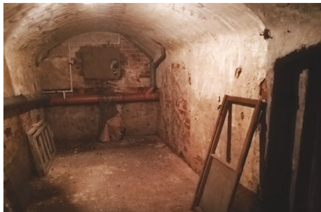
Piwnice. Fot. A. Krempa 2020 r.
