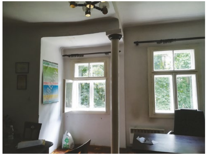
Jeden z pokoi mansardowych od strony wschodniej z wnękami wspartymi na drewnianych słupach. Fot. A. Krempa 2020 r.
